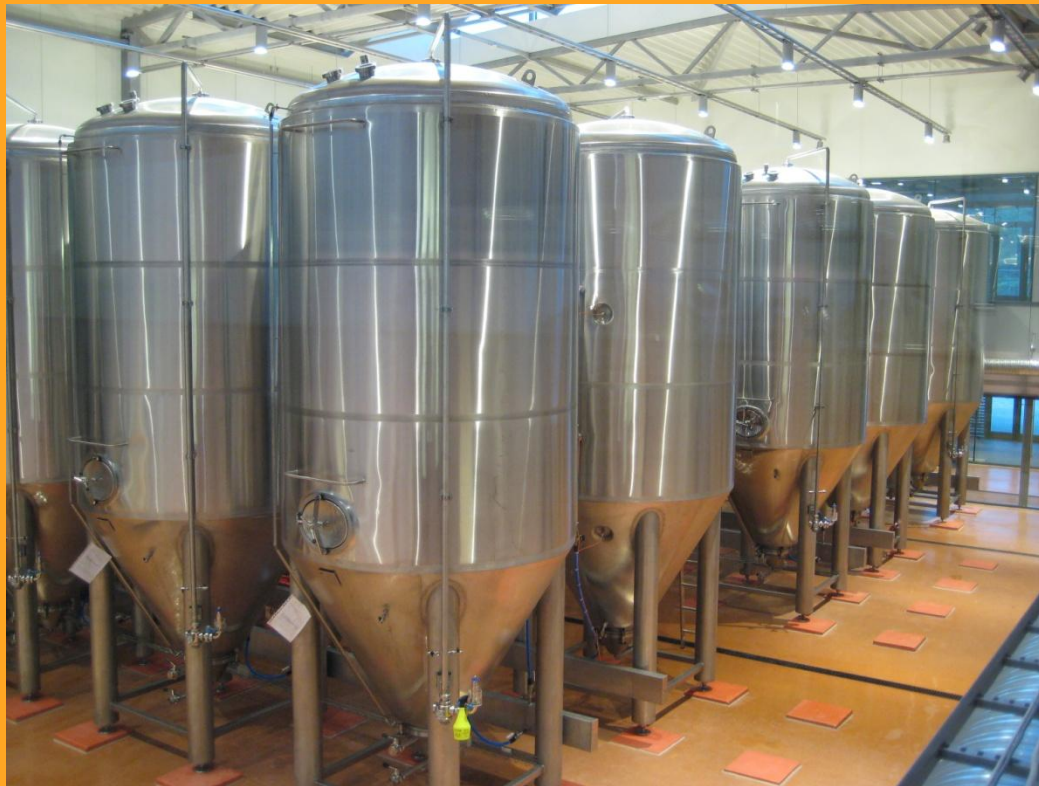
Бродильно-лагерный цех ( ЦКТ14 000 л на танк)
