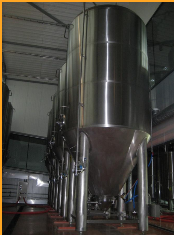
Бродильно-лагерный цех ( ЦКТ 14 000 л на танк)
